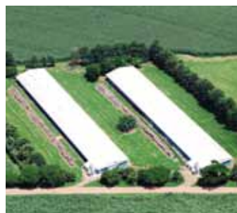
Galpões BOAV sendo modernizados
